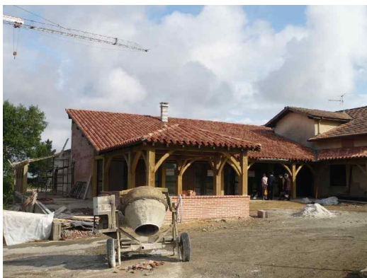
Le Bénédict en travaux.
