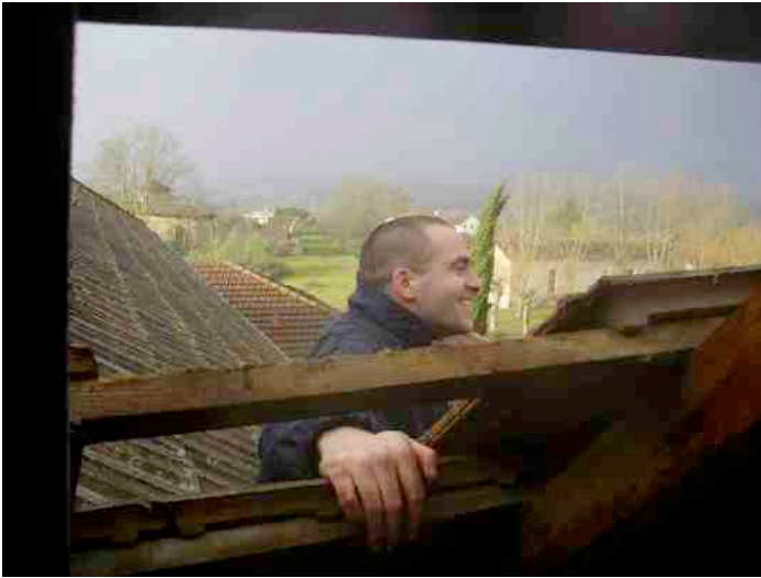
Réparation sur le toit du monastère.
